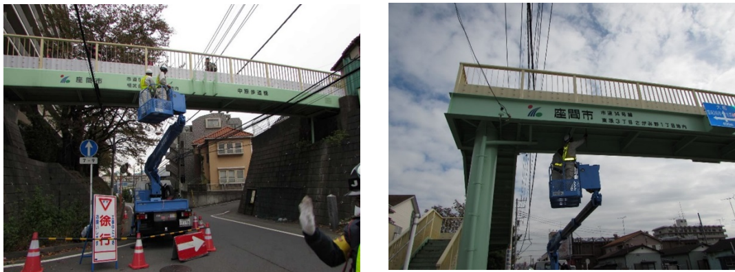
写真5-1 横断歩道橋点検状況
