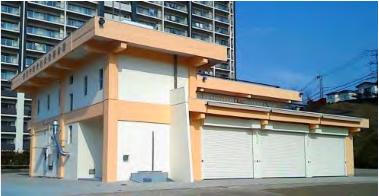
座間市総合防災備蓄倉庫
