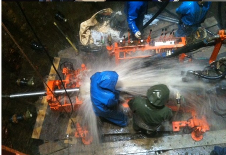
井戸改修工事（水道施設課）
