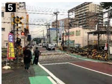
3・6・4 座間天台線 (座間駅周辺の踏切)
