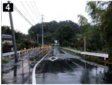
3・4・5 座間南林間線 (小田急小田原線踏切周辺)
