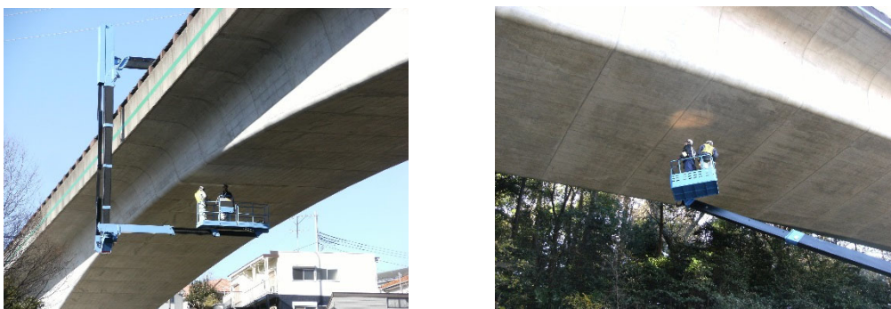
写真6-1 橋りょう点検状況
