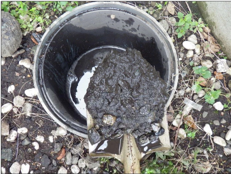
参考写真 清掃が不十分な雨水浸透ますの例
