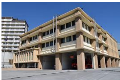
平成30年2月建設 新消防庁舎
